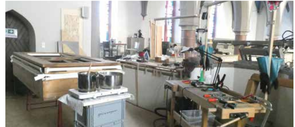
März 2021 - Baustelle auf der Empore
